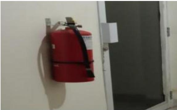
Gambar 4. Pemantapan Yang Tidak Ada Pada Pintu Dan Apar
