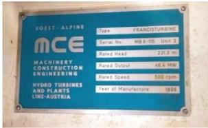
Gambar 7. Spesifikasi Turbin PLTA Way Besai
